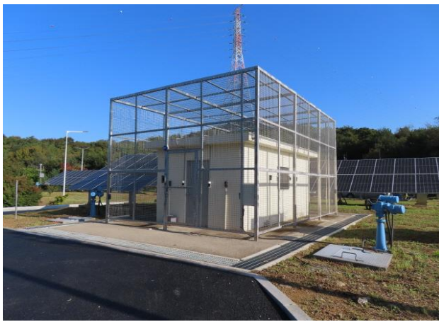
배수지 외부 전경
