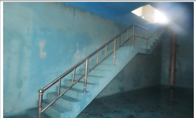
배수지 2지 안전난간 상태양호
