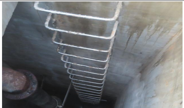
유출벨브실 1지 수직사다리 상태양호
