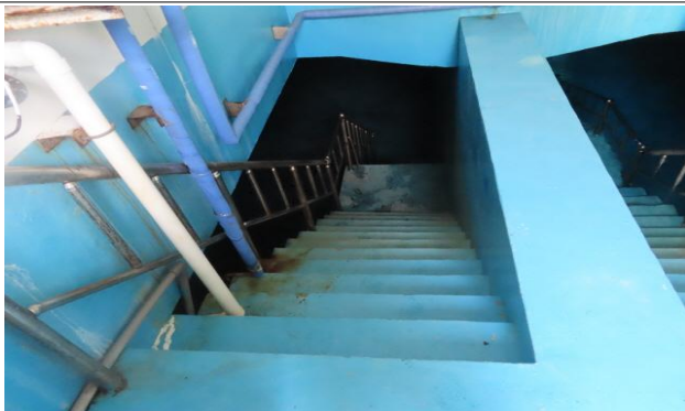
배수지 2지 안전난간 상태양호
