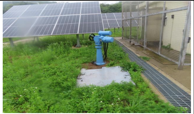
유입밸브실 2지 덮개 상태양호
