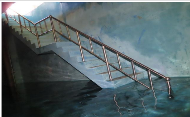
배수지 1지 안전난간 상태양호
