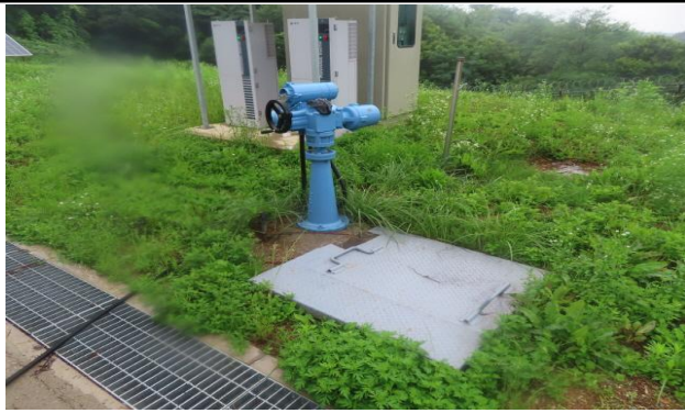
유입밸브실 1지 덮개 상태양호
