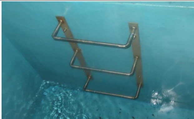
배수지 1지 집수정 진입사다리 상태양호
