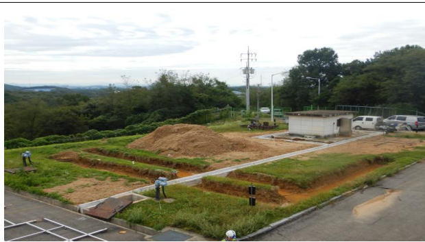
배수지 상부 전경 (2021년)
