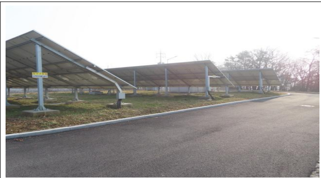
배수지 상부 전경 (2023년)
